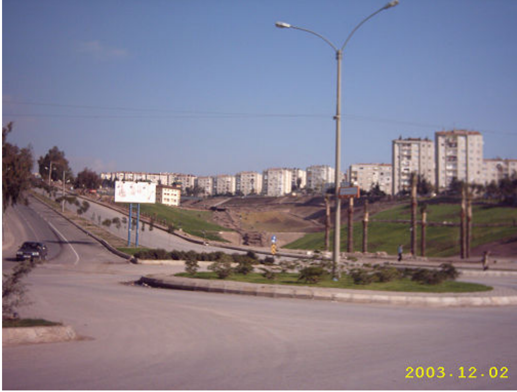
YEDİ GÖLLER İNŞAAT ÖNCESİ HALİ
